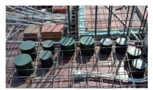
定各类管道走向位置,制作预 埋定位模板,在结构施工时直 的预埋件,与结构混凝土一起 浇筑,排水管下料、安装统一 尺寸,力争高层建筑实现无电 源装配式施工。如右图示意 (照片中星形中为在模板上预 埋的螺杆,与现浇板砼一起浇
