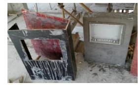
二次结构上强电箱(户箱),一般安装高度为1.8米,现场安装也可采取一定的方法来减少 后期的安装人工成本,此方法工地上正在安排工人进行施工人工、材料用量对比,初步觉得能够 节约部分人工。不过此方法需要土建施工时配合,如下图示意(吊装的C型钢可重复利用):
