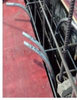
对于公用区域楼道、电梯前室、水电管 井内上下连通的电源线管、应急灯、疏散指 示灯以及各类智能化预埋线管,宜按层高-次性安装到位,如层高2.9米,第一个线盒标 高定位后,上一层的线管预埋时,即为2.9米 减去一个线盒的长度,加两个螺接头或进盒 锁母长度,此类管子较少,可在后场预先加 工完成,直接吊到现场安装,可节约现场安 装时间, 甚至可以不要层层测量安装高度, 每隔几层校核一下标高即可。
