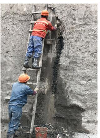
如果遇到漏水涌砂严重而可能危及基坑或周围建筑物安全时，应采取紧急措施，对其进行处理。漏水孔很大时，用土袋堆堵，然后用化学灌浆浆封闭，止水后，再拆除土袋。
