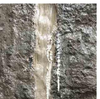
对于地下连续墙渗漏的问题，特别是兼作地下室外墙的地下连续墙的渗漏，宜标本兼治，且以治本为主。施工人员第一时间采取合理有效的应急措施，可及时消除渗漏风险，减少渗漏对周边环境的影响，降低工程自身损失，起到事半功倍的效果。
