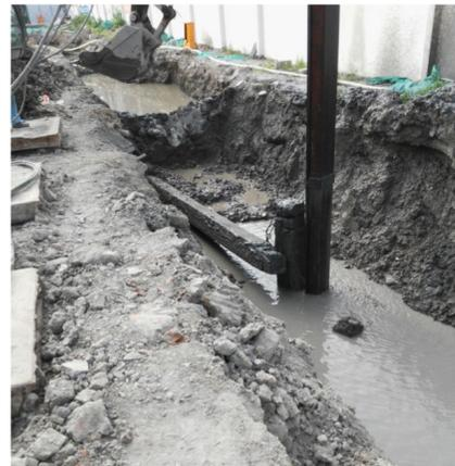
图五 方桩拔出
