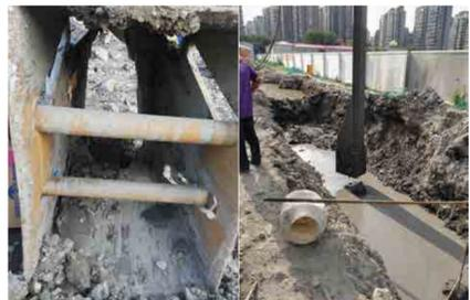
图一 特制套管装置 图二 对准桩身下套管
