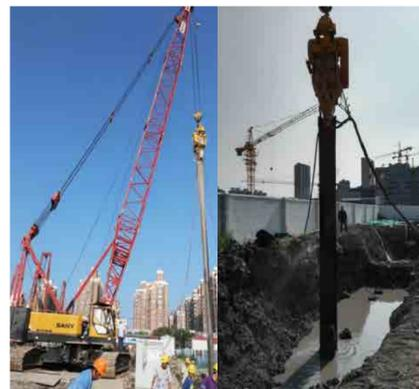
图三 钢板桩下沉 图四 桩身随钢板桩上升
